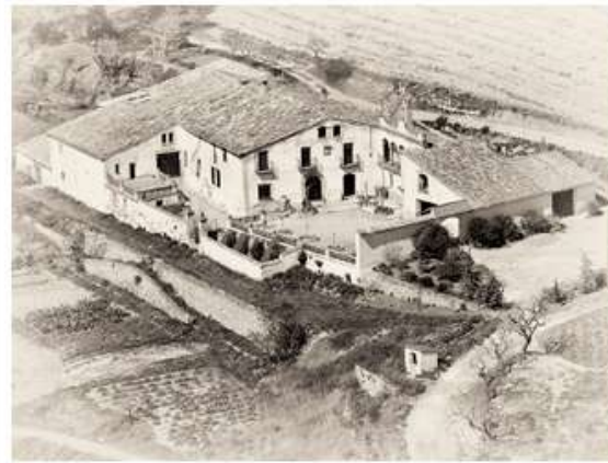
Foundation Casa Sala
